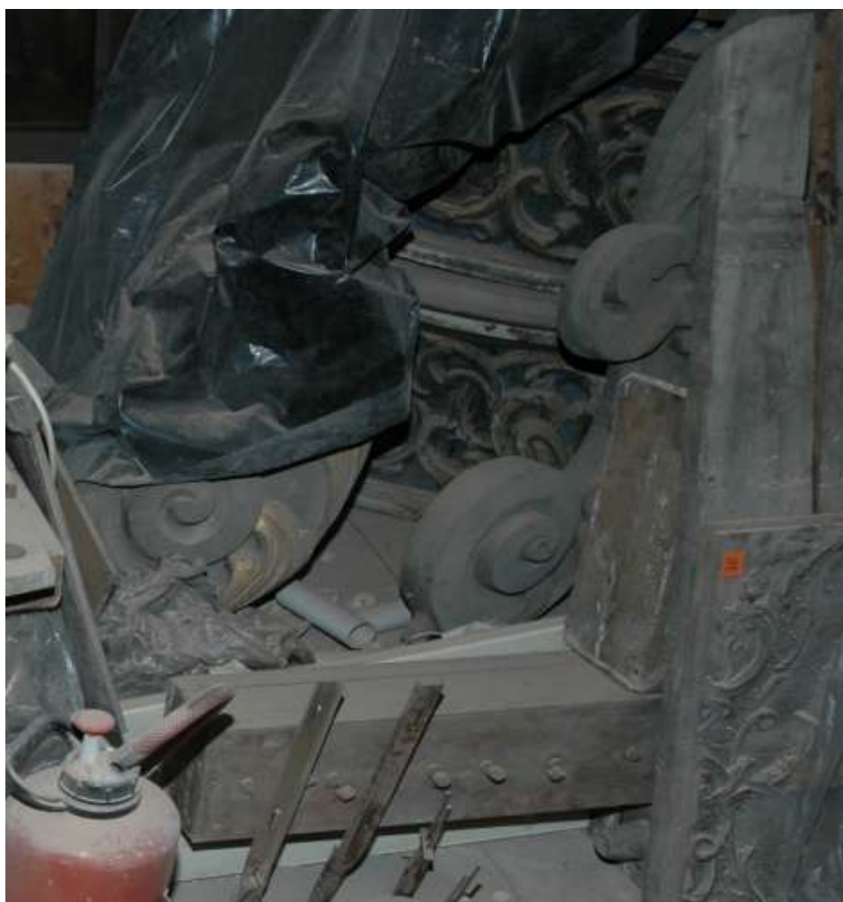
Ryc.: 21. Konsole basowe z wieżyc Nitrowskiego – stan zachowania w 2015, fot. P. Lewko, 03.09.2015.
