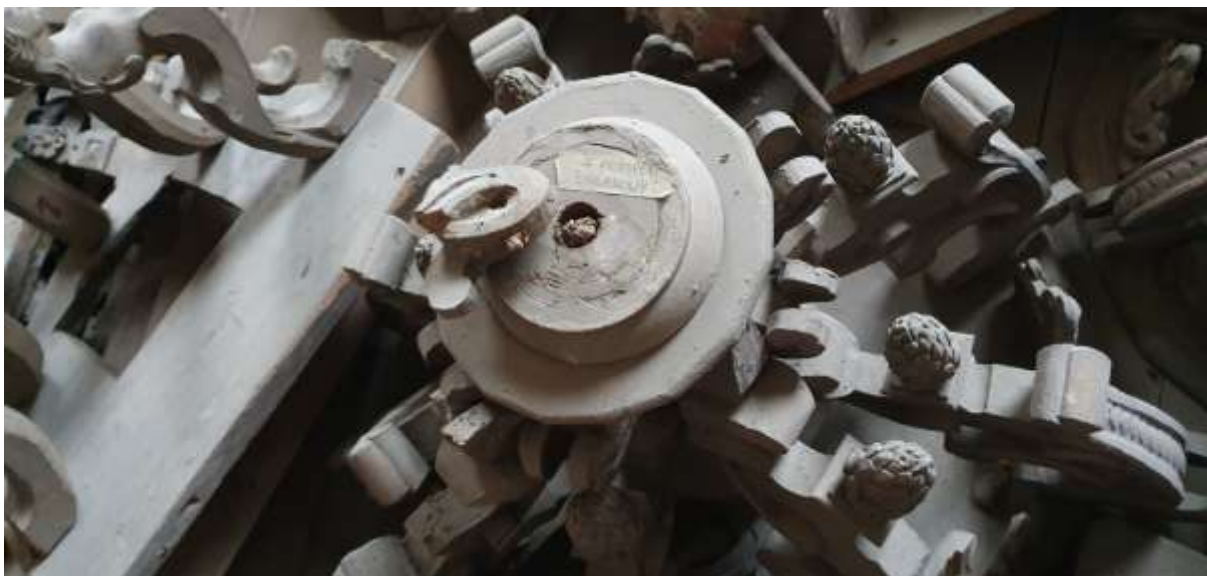
Ryc.: 73. Spływ wieżycy środkowej części Haucka, Fot. P. Lewko, 27.01.2024.
