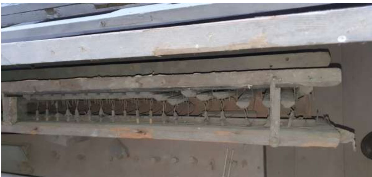
Ryc.: 88. Klapy wiatrownicy Fischera od frontu (z góry). Fot. P. Lewko, 27.01.2024.
