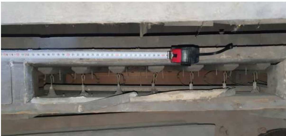
Ryc.: 91. Komora klap i druty prowadzące okalające klapy. Fot. P. Lewko, 27.01.2024.
